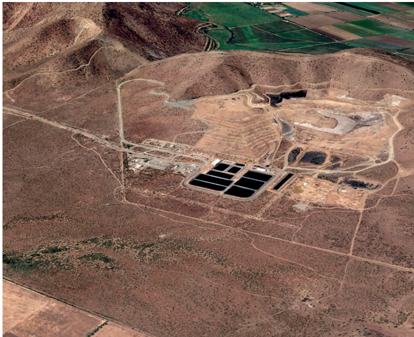
ILUSTRACIÓN 2: Relleno Sanitario Santiago Poniente
